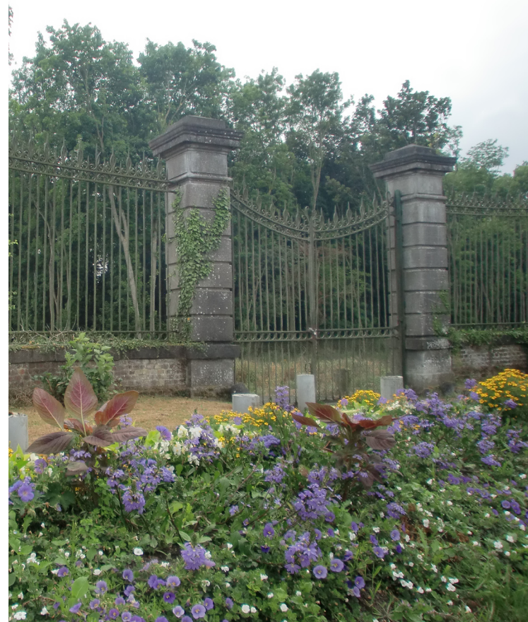
Grille d'accès au parc du château (à l'entrée du village, rue d'en haut)
